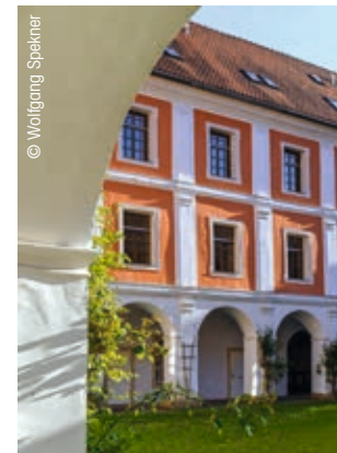
Das JUFA-Hotel bietet Zimmer in den alther- würdigen Gemäuern des ehemaligen Jesuitenklosters.
