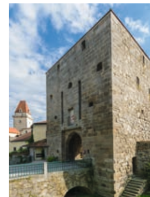
Das Böhmerntor und der Bergfried, zwei der neun Türme und Tore der mittelalterlichen Stadtbefestigung.
