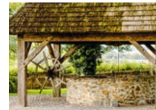
Der Burgbrunnen wurde, nachdem man ihn 1915 zugeschüttet hatte, im Jahr 2003 wiederentdeckt.
